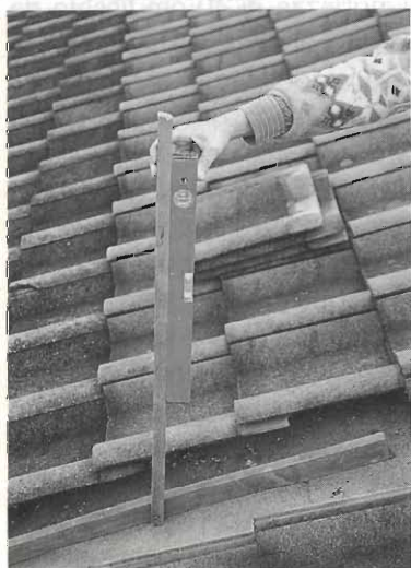
Foto 1 - Determinazione dell'angolo di saldatura tra piastra e palo di sostegno.
